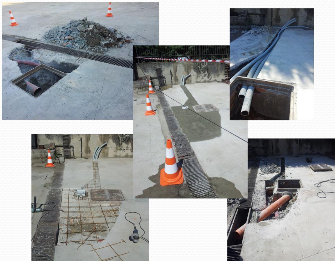
Lavori per l'allestimento del sito sperimentale "Autodemolitore"
