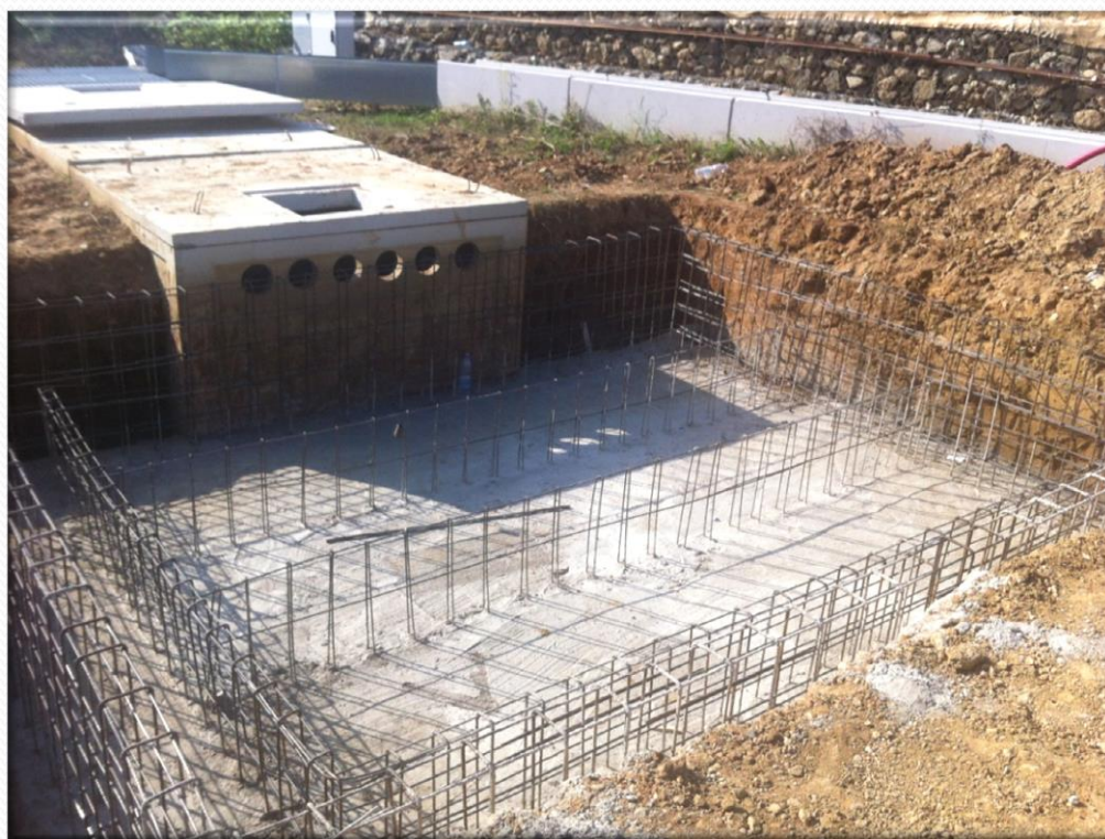
Unità di filtrazione a valle della vasca di sedimentazione in fase di realizzazione
