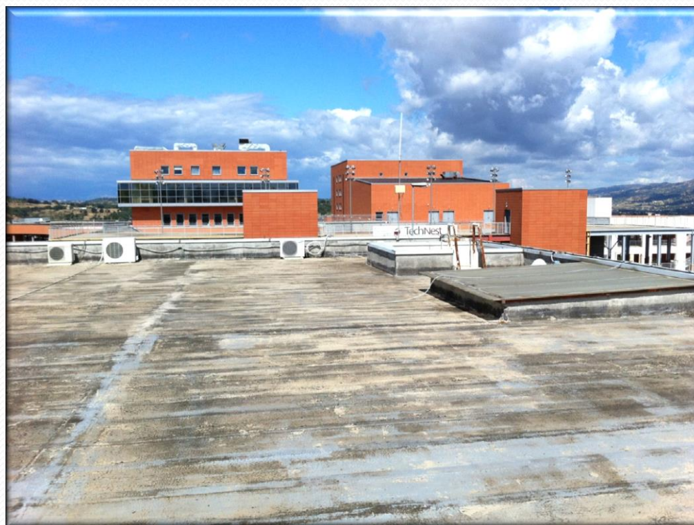
Tetto del cubo 46/C prima dell'installazione (vista lato sud)
