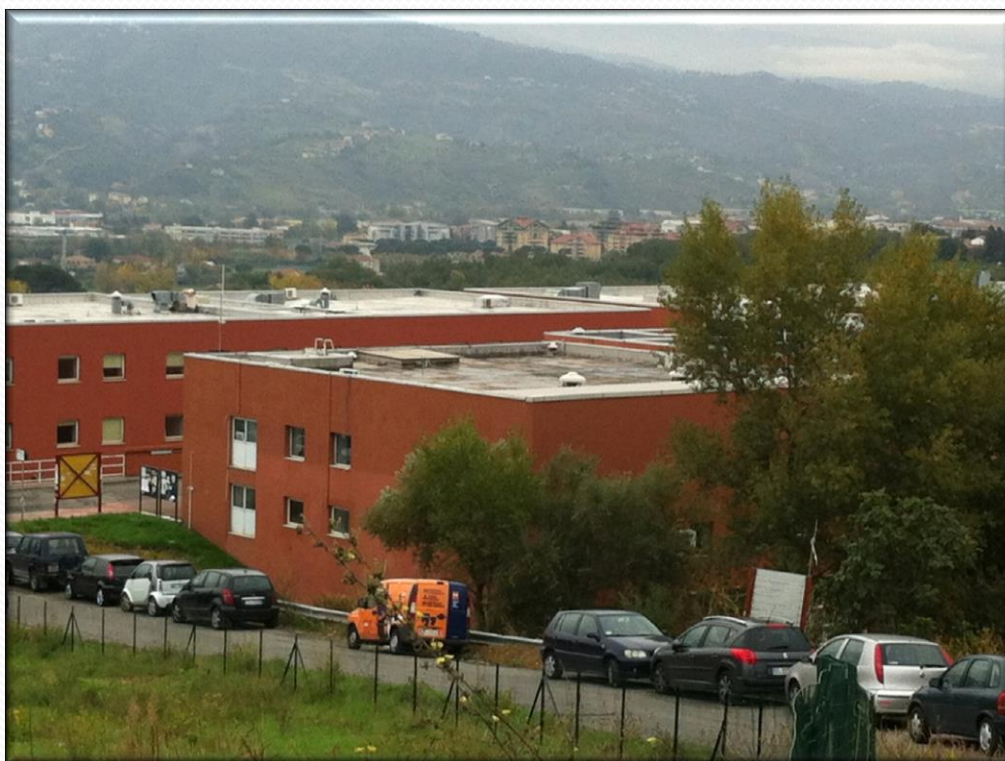
Cubo 46/C prima dell'installazione del Tetto verde
