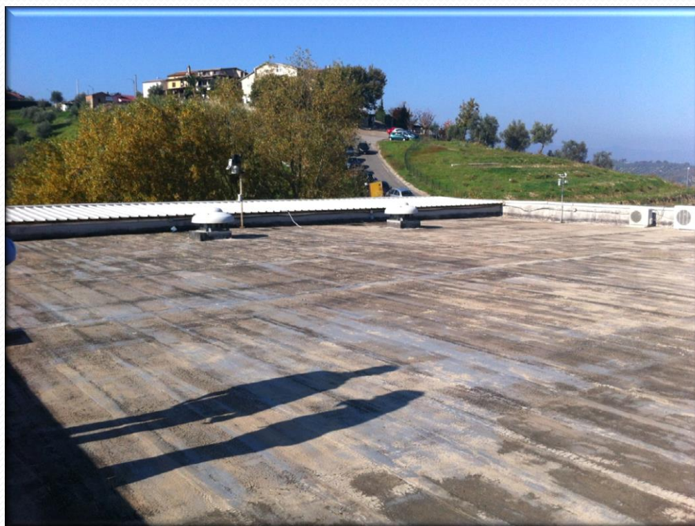
Tetto del cubo 46/C prima dell'installazione (vista lato ovest)
