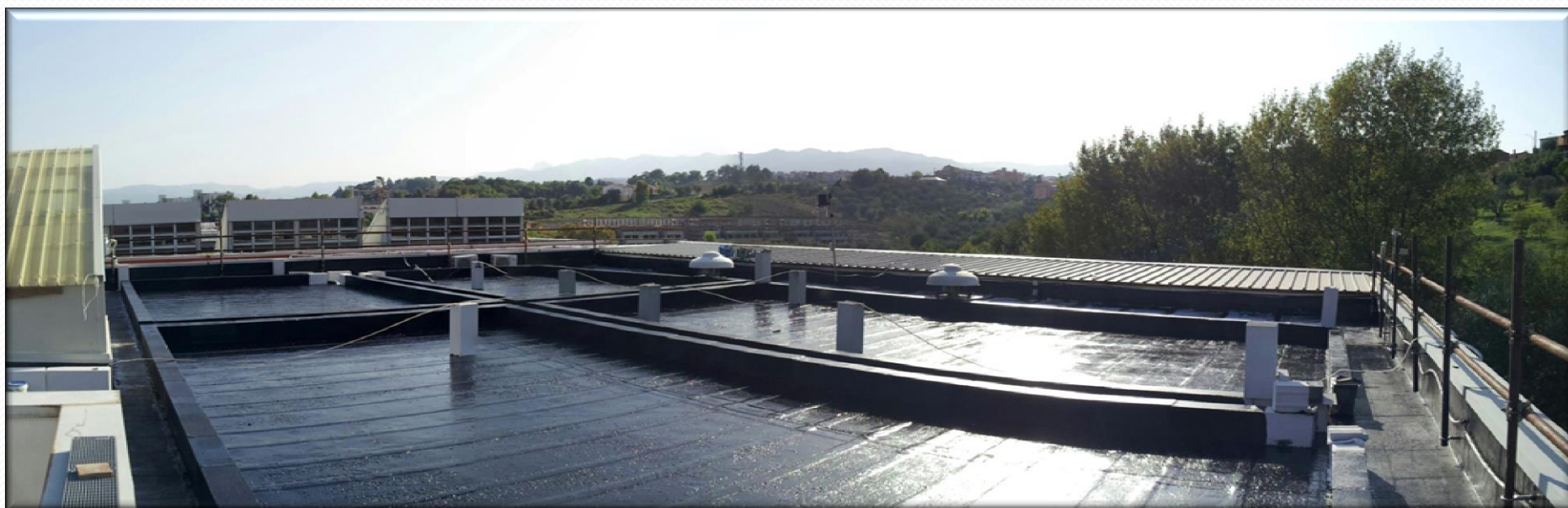
Compartimentazione del tetto (vista lato nord)
