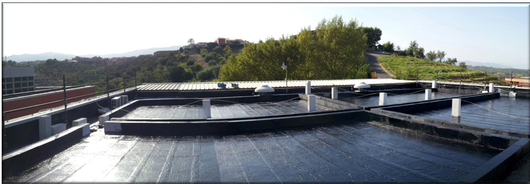
← Compartimentazione del tetto (vista lato sud) →
