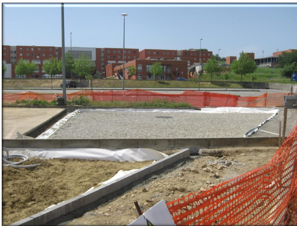
Realizzazione dello strato di accumulo (sub-base e base) delle acque filtrate nella pavimentazione permeabile
