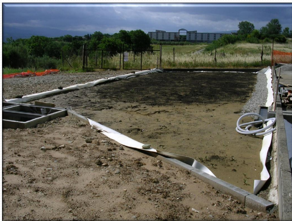
Strato di terreno vegetale per la semina della vegetazione autoctona nella fascia filtro
