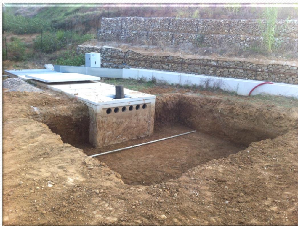
Unità di filtrazione in fase di realizzazione
